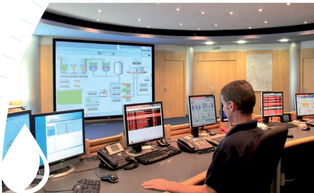
Panorama au Centre de Télégestion de la Société des Eaux de Marseille. Contrôle permanent et à distance de plus de 850 ouvrages hydrauliques, collecte et traitement de près de 95.000 informations recueillies en temps réel.
