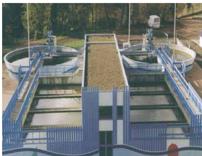
Usine de production d'eau potable du Gour du Puy à Montluçon
