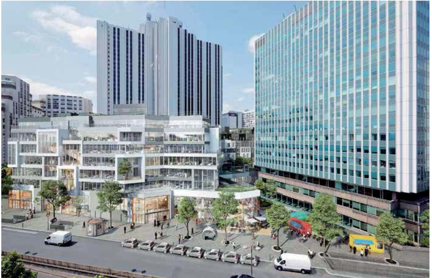
Ilot « les Ateliers Gaîté », transformation du quartier Montparnasse
