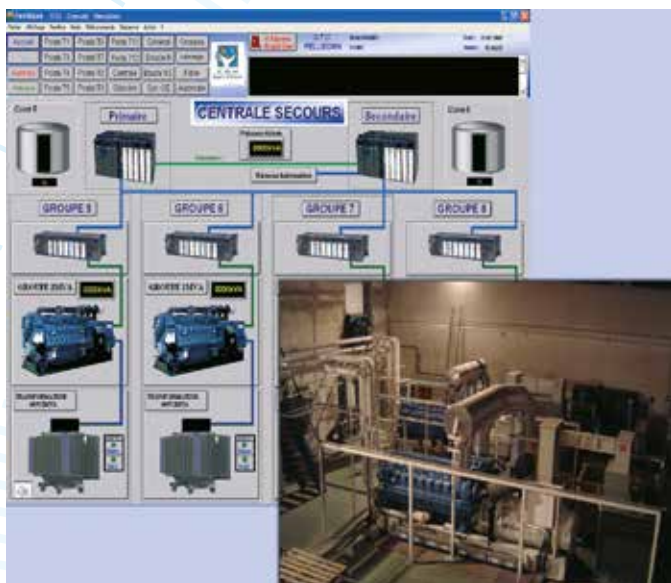
Vue synoptique Panorama correspondant à la supervision des groupes électrogènes de l'hôpital de Pellegrin
