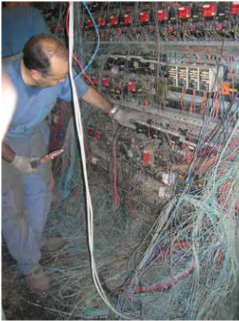
Démontage local BT
